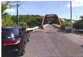
HTB～江上大島橋手前
